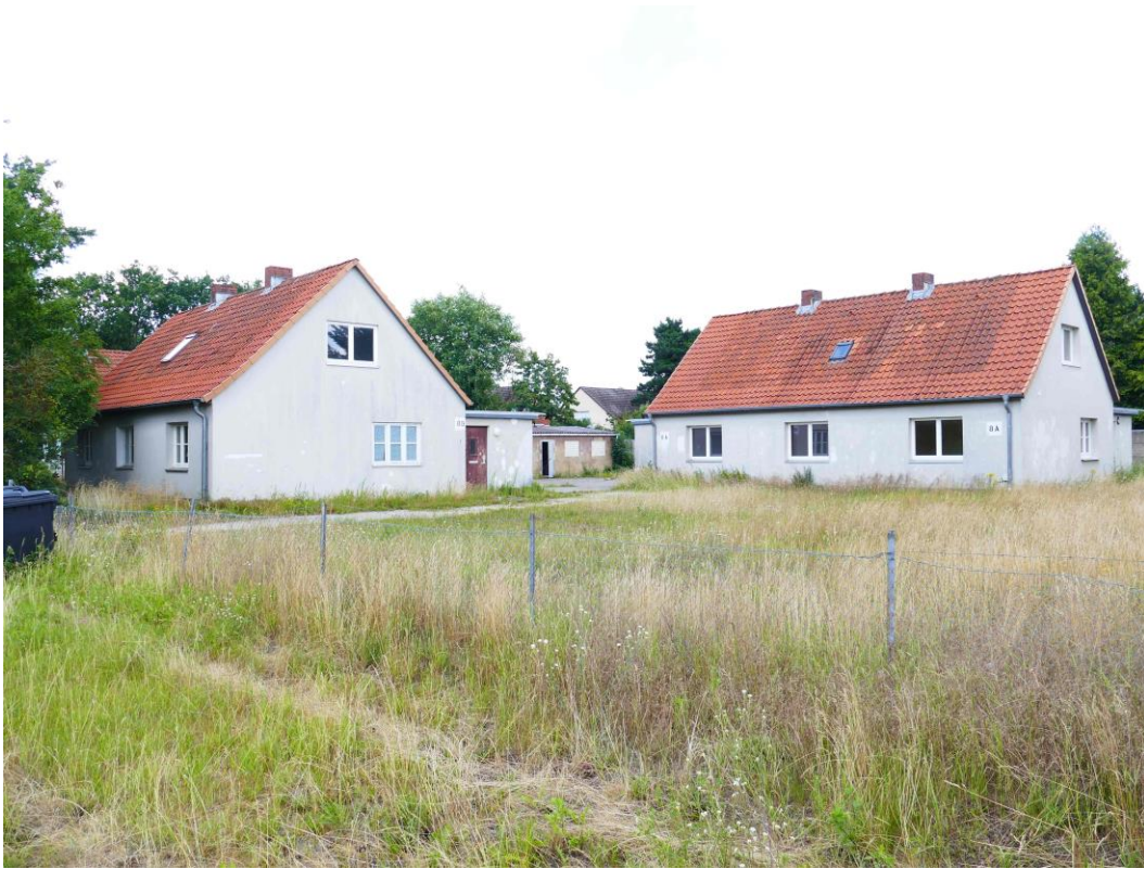
Abb1: UG-Ostteil mit zum Abriss vorgesehenen Gebäuden
