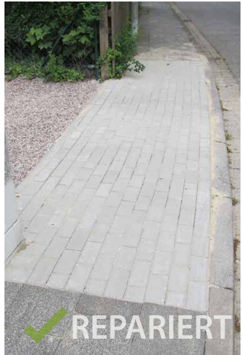
Fertige Zufahrt mit grauen Rechteckpflaster.
