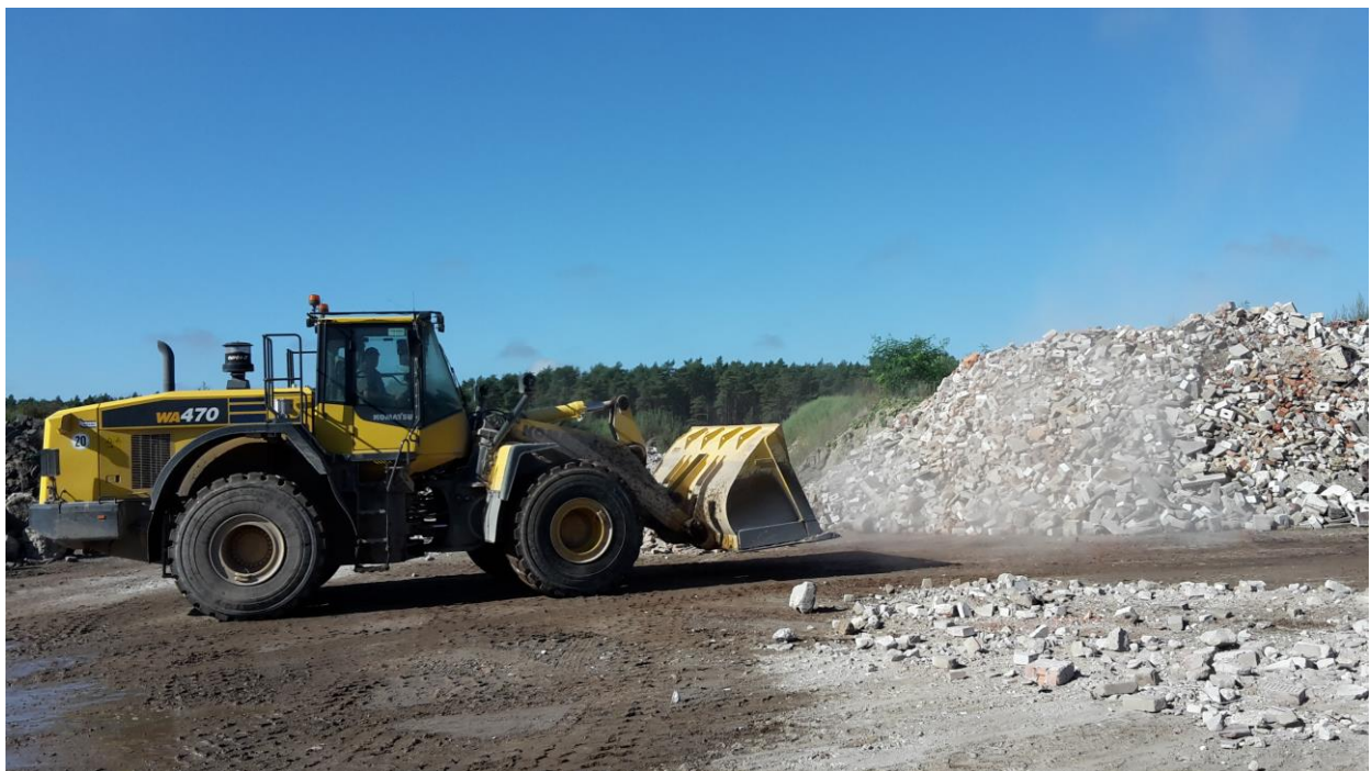
Abbildung 4: Umschlag Bau- und Abbruchabfälle mit dem Radlader
