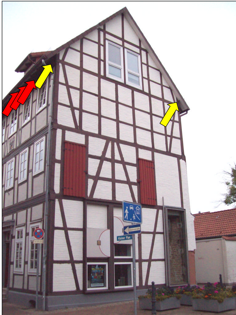
Abb. 3: Vorkommen von Gebäudebrütern im Dachbereich am Haus Kleiner Plan 3 (Haussperling = rot, Mauersegler = gelb).
